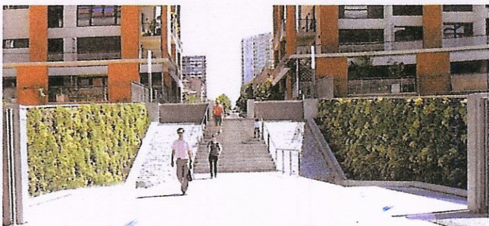
→ Le second mur de Toulouse, procédé Végétalis®, deux parcelles aux orientations différentes, nord-ouest et sud-est.
