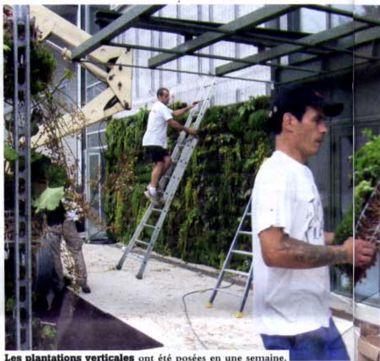
Les plantations verticales ont été posées en une semaine.
